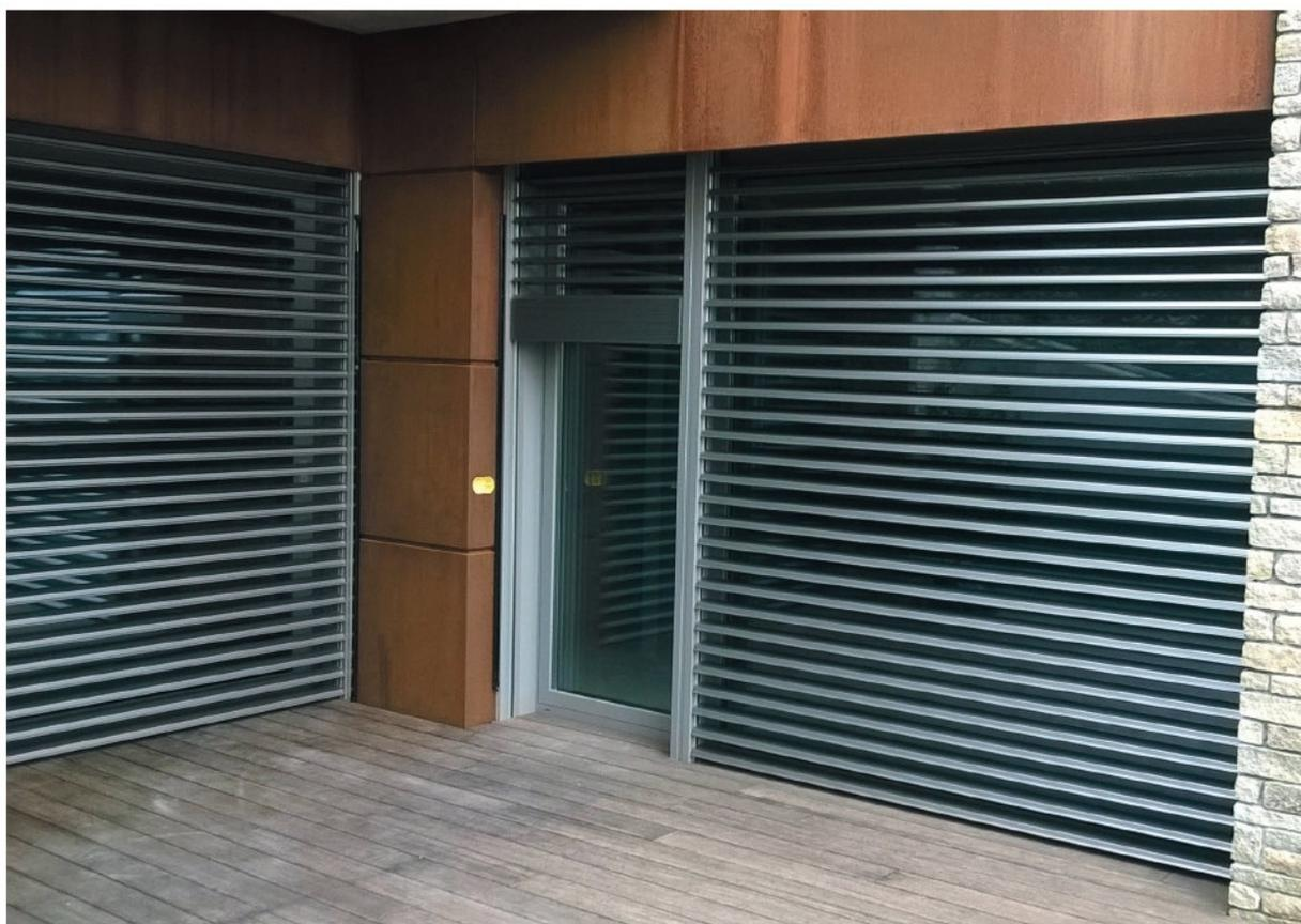
**Metalunic® V** rimane impassibile. Costruzione **autoportante** senza collegamenti verticali; i meccanismi di sollevamento e inclinazione sono integrati nelle guide di scorrimento. La robusta meccanica offre una sicurezza antisollevamento affidabile. Il profilo delle lamelle, particolarmente resistente al piegamento, è anche estremamente elegante e ideale per distinguersi da un punto di vista architettonico.
