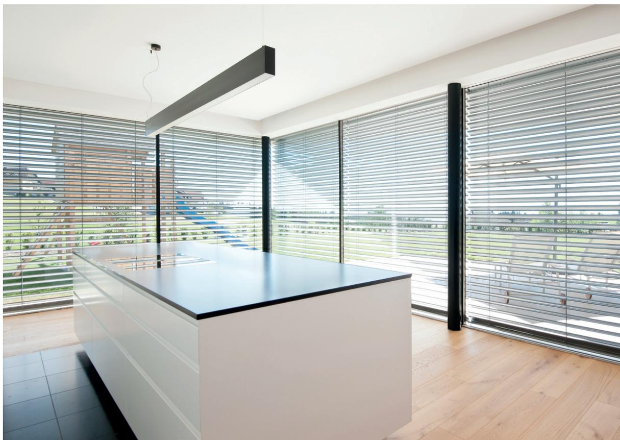
La forma è a “Z” o “S” sagomata e bordata ai lati per assicurare una maggiore robustezza. Nella parte esterna della lama è inserito un profilo in pvc grigio con funzione antirumore. Alle estremità delle lame sono posizionati dei pivotti in zinco pressofuso, fissati in maniera alternata; mentre sulla bordatura della lama sono inseriti dei ganci in PVC (sistema brevettato ECN), in corrispondenza dei fori del texband. Questi ganci consentono l’ancoraggio del terylene alle lame.
