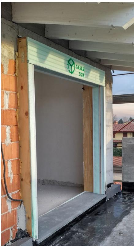
Il serramento può essere posato in qualsiasi posizione, verso l'esterno, a filo muro interno oppure al centro. Qualunque sia la collocazione della finestra, non ci sarà bisogno di entrare con il cappotto nella mazzetta perché all'isolamento ci pensa già l'EPS (Expanded PolyStyrene, polistirene espanso) del GREEN BOX: meno lavoro per il cappottista e meno costi.
