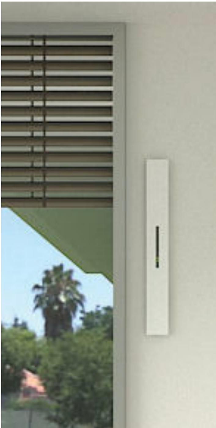
I sistemi più moderni di ventilazione meccanica controllata decentralizzati sono quelli a doppio flusso continuo, dotati di scambiatore di calore ad alta efficienza, meglio se entalpici e filtrazione spinta dell'aria immessa.
